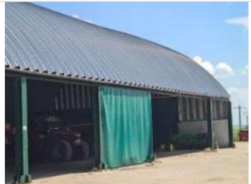
C7 – hala depozitare
