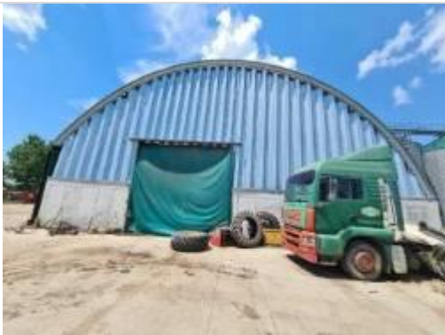
C7 – hala depozitare
