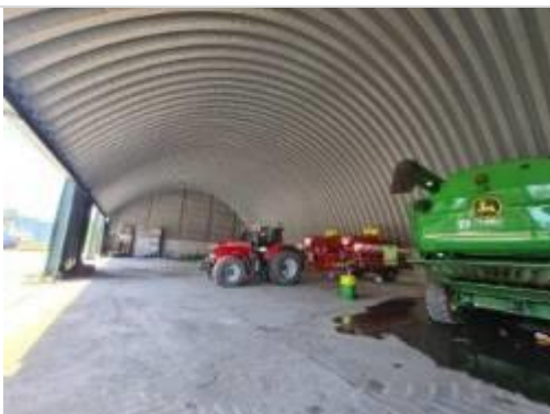
C7 – hala depozitare
