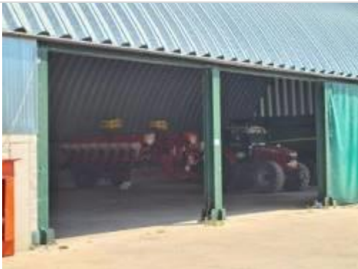
C7 – hala depozitare
