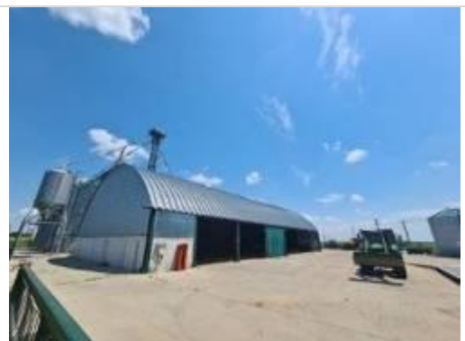
C7 – hala depozitare
