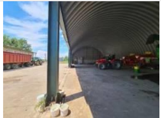
C7 – hala depozitare
